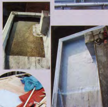
防水部分補修
