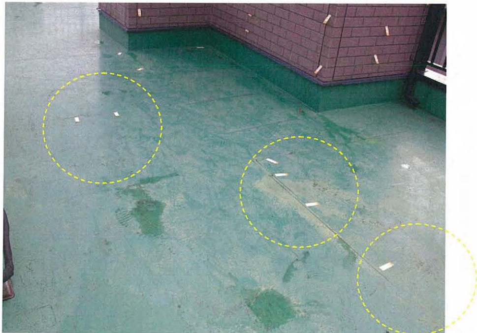
排水ドレン下部防水材の亀裂
